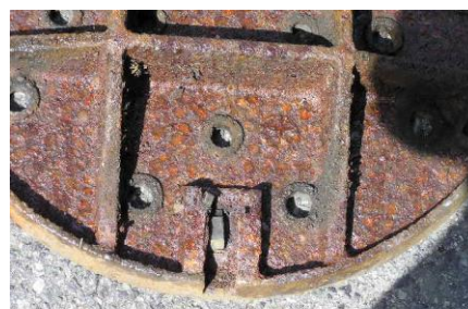
図 1-2. 蝶番部品の脱落により機能が消失した蓋
